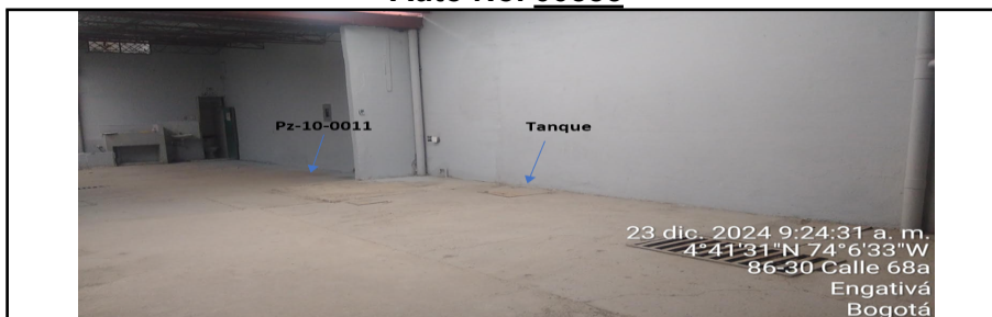
Fotografía No. 2 Ubicación del pozo objeto de visita y del tanque de almacenamiento
